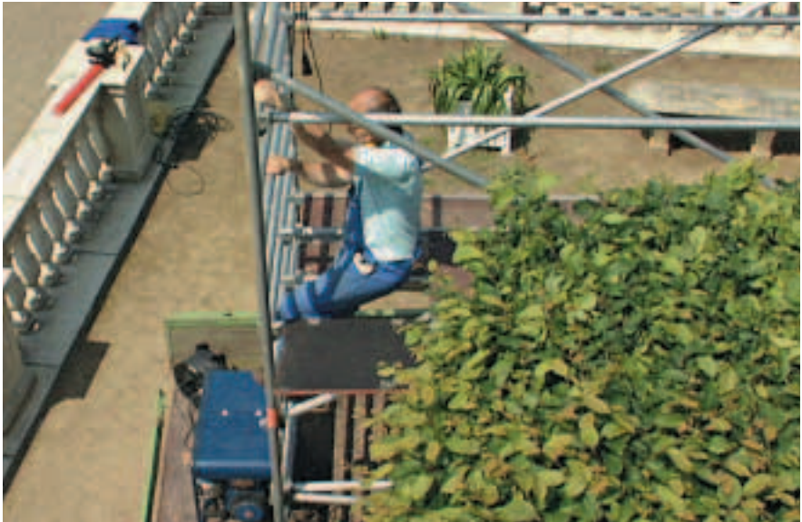
Für höhere Hecken bieten Gerüste einen sicheren Standplatz.
