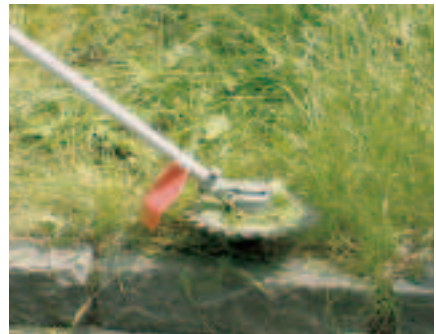
Einsatz des Freischneiders mit speziellen Werkzeugen im Straßenbereich.
