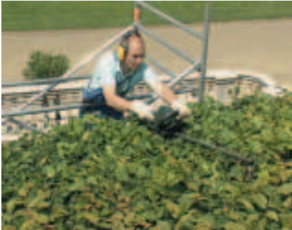
Sicherer Halt beim Heckenschnitt vom Gerüst aus.
