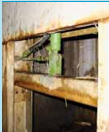
... damit bestimmte Komponenten des Schiebers (Hydraulikschläuche, Bolzen, Gestänge) überprüft werden können.
