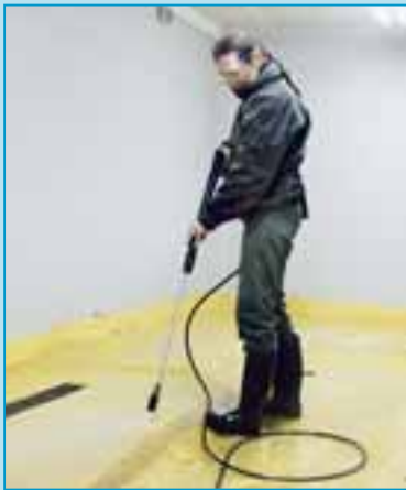
Hochdruckreinigung mit Persönlicher Schutzausrüstung. In bestimmten Fällen ist zusätzlich Atemschutz zu tragen.
