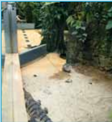
Schwenkbarer Schieber zum Trennen zweier Gehege. Durch Ausklappen kann die Höhe des Schiebers vergrößert werden.
