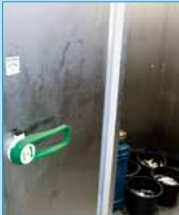
Kühlraumtür von innen mit gekennzeichnetem Griff
