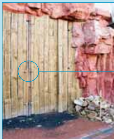
Gelegentlich genutzte Zugänge zu Außengeländen mit besonders gefährlichen Tieren sind besonders zu sichern. Das Öffnen der Zugänge ist nur mit besonderen Werkzeugen oder speziellen Schlüsseln, die besonders verwahrt sind, möglich.
