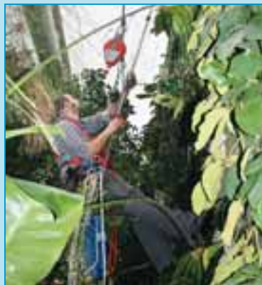
Schlecht geplant, aber gut gelöst – fehlender Wartungsgang für Grünpflegearbeiten wird durch Seilsicherung kompensiert
