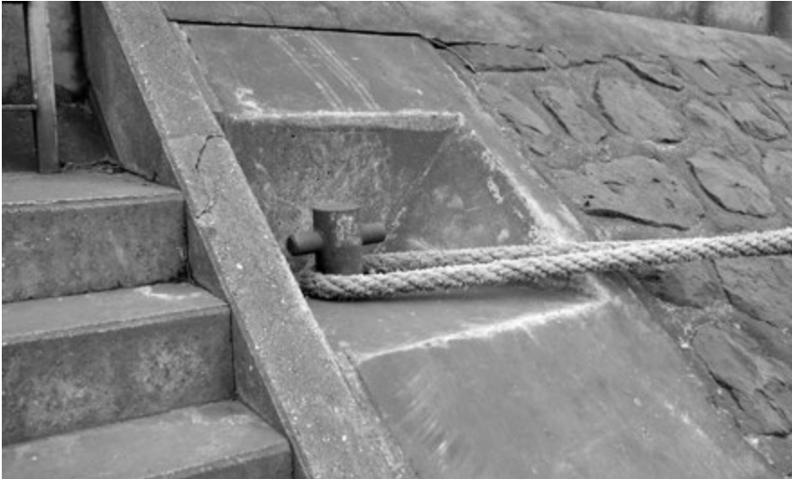
Abbildung 3: Festmachepoller neben einer Böschungstreppe. Treppe nicht mit der Festmacheleine kreuzen. – Stolpergefahr –
