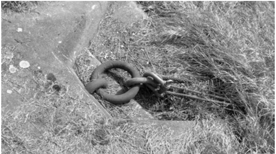
Abbildung 1: Der Schäkel gehört in den Ring und nicht an einen anderen Schäkel. Auf Festigkeit und Haltekraft des Ringes achten!
