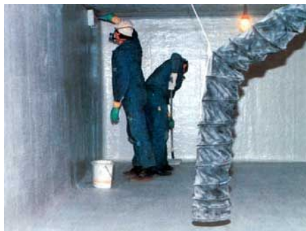
Abbildung 11: Anbringen einer Polyesterbeschichtung auf Beton in einem geschlossenen Raum (Laminieren)
