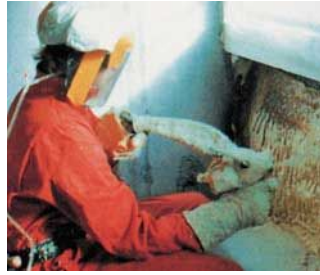
Abbildung 4: Ausschäumen eines Hohlraums
