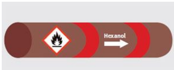
Abbildung 13c: Innerbetriebliche Kennzeichnung von Rohrleitungen gemäß ASR A1.3 und TRGS 201(83)(14) (28)
