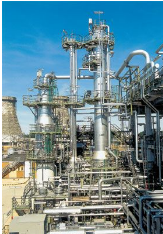
Abbildung 10: Destillationskolonnen prägen aufgrund ihrer Abmessungen oft das Bild von Chemieanlagen
