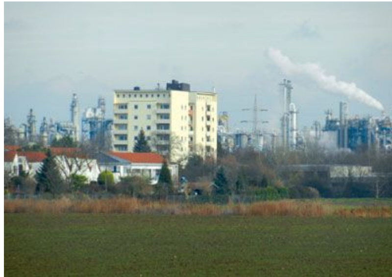
Abbildung 1: Standort und Umgebung einer Chemieanlage beeinflussen das Sicherheitskonzept
