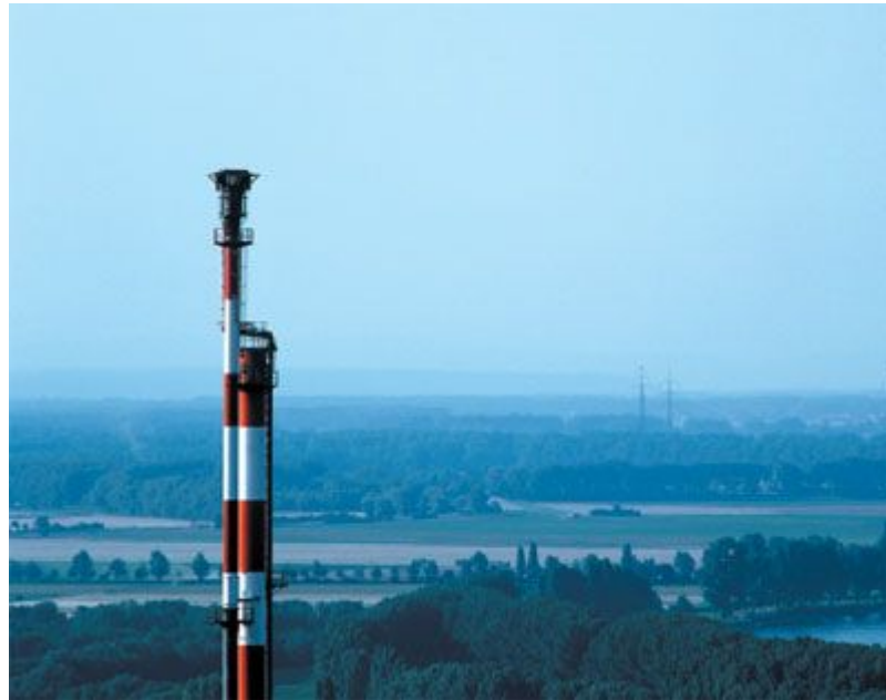
Abbildung 15: Fackeln dienen der gefahrlosen Ableitung von Stoffen
