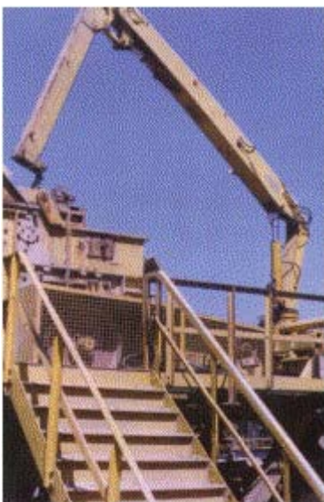
Abb. 22: Treppenzugang zu einer Recyclinganlage
