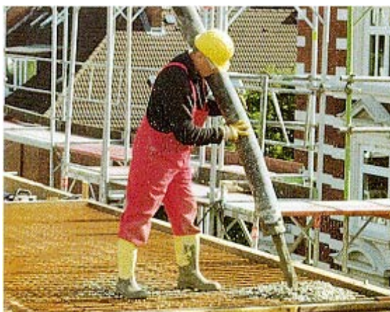
Abb. 33: Führen des Endschlaches
