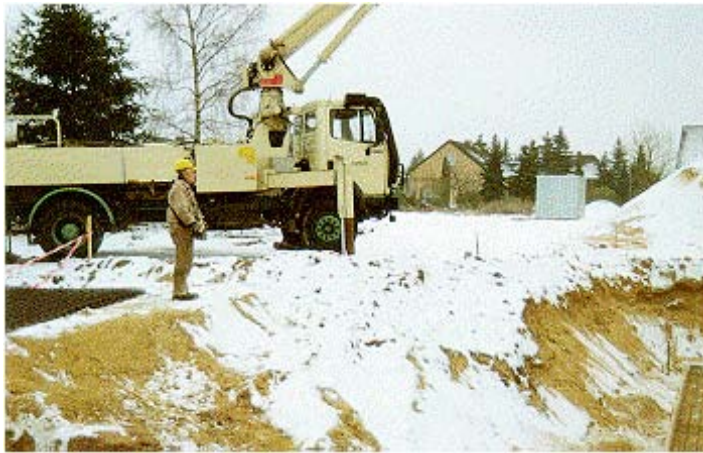
Abb. 30: Standplatz mit guter Übersicht nahe der Einbaustelle
