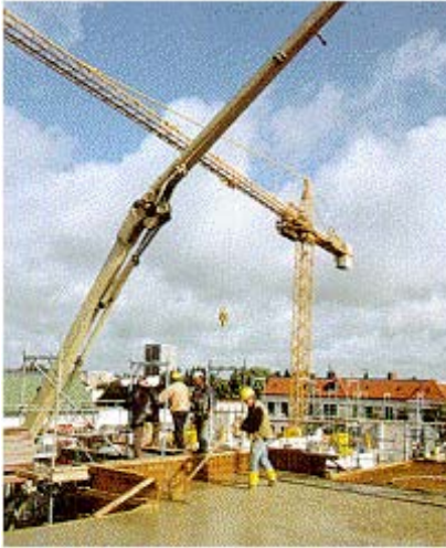
Abb. 10: Überschneiden der Arbeitsbereiche von Betonpumpe und Turmdrehkran
