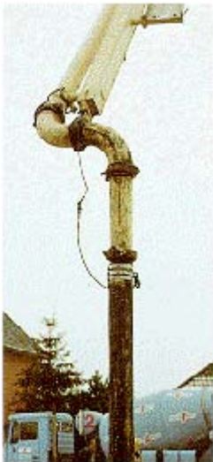
Abb. 19: Seilsicherung für den Endschlauch
