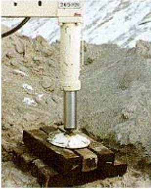
Abb. 13: Stützen mit Kanthölzern unterbaut
