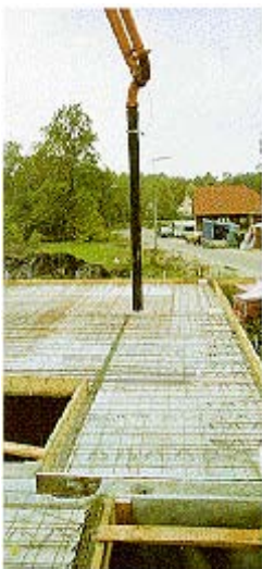
Abb. 20: Freies Schlauchende ohne Einbindung
