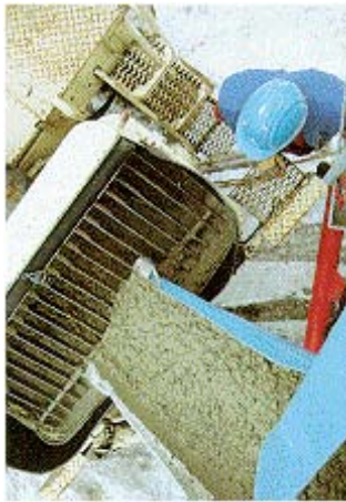
Abb. 24: Betonzugabe in den Aufgabetrichter
