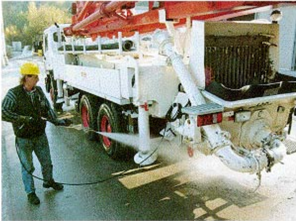
Abb. 40: Arbeiten mit dem Druckstrahlgerät
