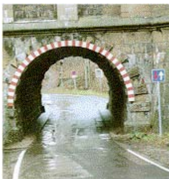
Abb. 5: Durchfahrtshöhe und -breite sind hier zu beachten
