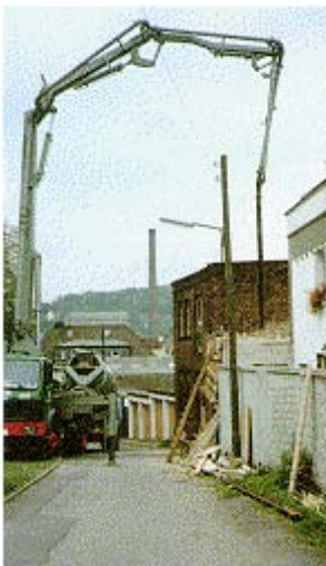
Abb. 7: Hier ist die Freileitung spannungsfrei geschaltet
