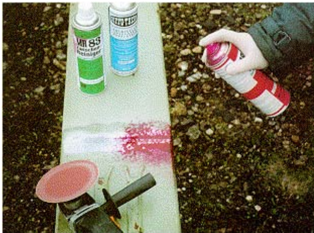
Abb. 47: Prüflack zur Feststellung von Rissen am Verteilmast
