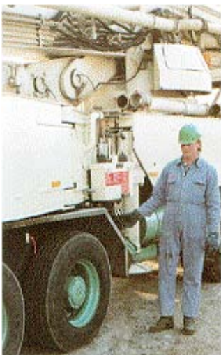
Abb. 12: Ausfahren der Ausleger, Geräteführer am Steuerhebel
