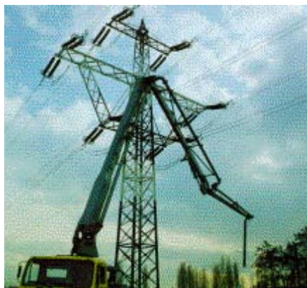
Abb. 18: Verteilermast in der Nähe einer Freileitung
