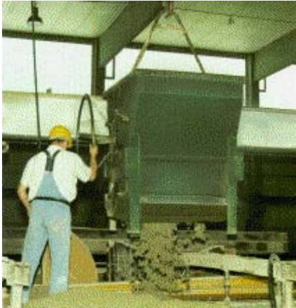
Abb. 5: Kran mit Betonkübel
