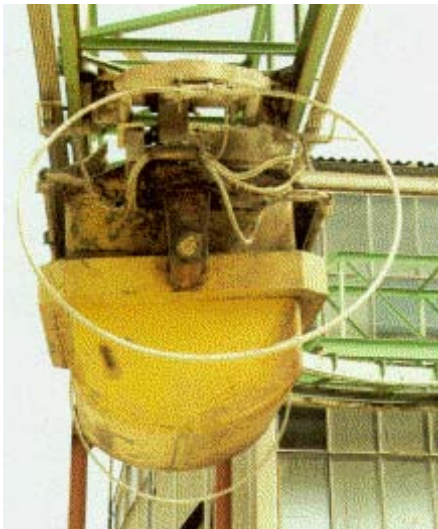
Abb. 3: Kübel einer Schienenhängebahn mit Abschaltbügel
