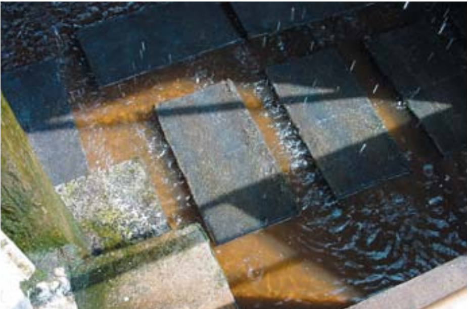
Bild 5-8: Kühlturm mit Metallkatalysatoren
