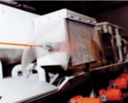
Bild 3-6: Reißleine, der Schalter wurde wegen möglicher Verschmutzung und gegen Spritzer abgedeckt
