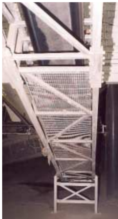
Abb. 21: Vollständige Verkleidung über einem Verkehrsweg
