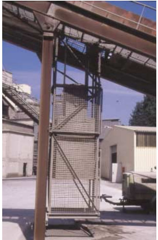
Abb. 17: Verdeckung einer Spannstation
