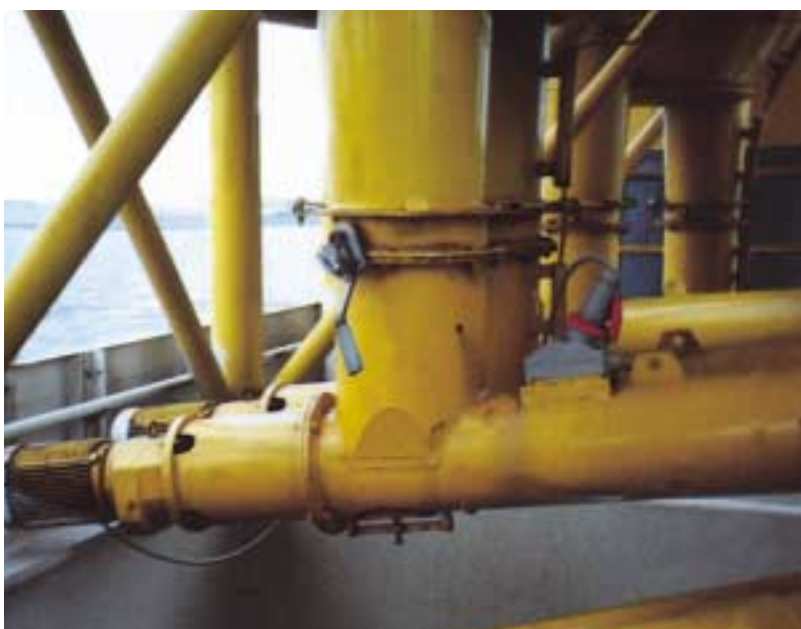
Abb. 41: Allpolige Trennung durch Steckvorrichtung
