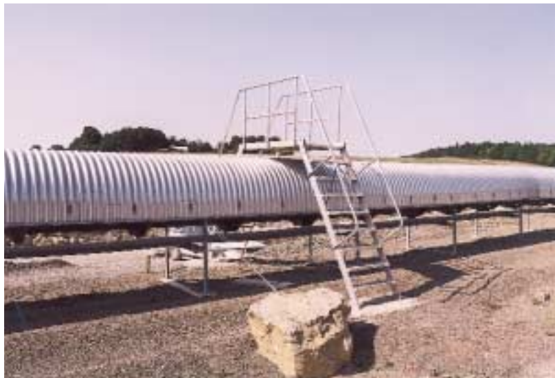
Abb. 47: Sicher zu überqueren durch den Laufsteg
