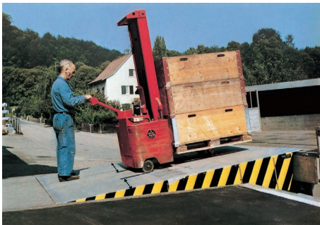
Bild 2: Ladebrücke in ausreichender Breite.
