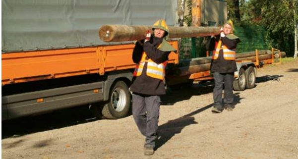
Bild 7: Manueller Masttransport durch 2 Personen. Die Mitarbeiter verwenden einen Schulterenschutz mit Haube. Bei einem Mastgewicht von ca. 90 kg sollte ein manueller Transport nur gelegentlich erfolgen.
