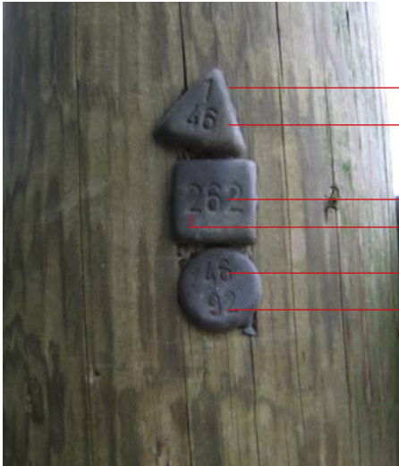
Bild 15: Beispiel für eine geeignete Kennzeichnung eines Telekommunikationsholzmastes. Mit der Befestigung eines Mastnagels in definiertem Abstand zum Mastfuß ist die ausreichende Einbautiefe festzustellen.
