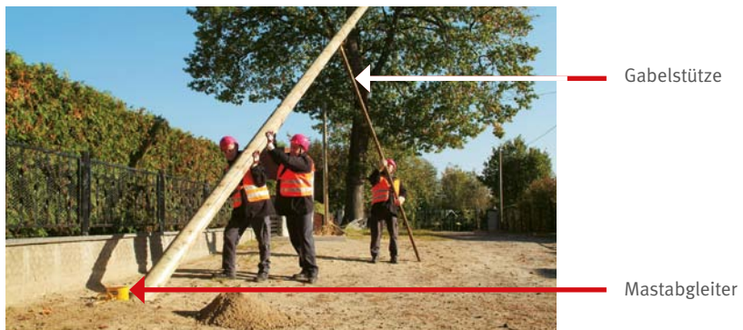
Bild 10: Beispiel für ein manuelles Stellen eines Telekommunikations-Holzmastes unter Verwendung eines Mastableiters und einer Gabelstütze
