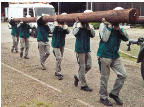
Bild 8: Manueller Transport eines Freileitungs-Holzastes durch eine Personengruppe
