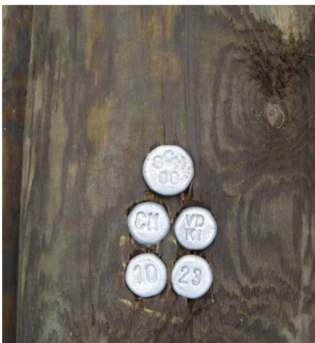
Bild 15: Beispiel für eine geeignete Kennzeichnung eines Telekommunikationsholzmastes. Mit der Befestigung eines Mastnagels in definiertem Abstand zum Mastfuß ist die ausreichende Einbautiefe festzustellen.
