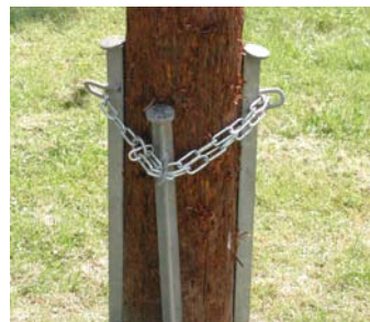
Bild 19: Beispiel für eine Mastfußsicherung
