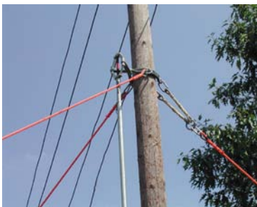
Bild 18: Mastsicherungsgerät
