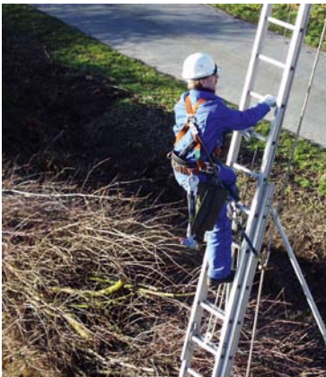
Bild 23: Einsatz einer Schiebeleiter mit zusätzlicher Abstützung
