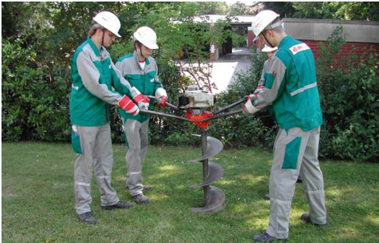
Bild 9: Beispiel für den Einsatz eines motorisch betriebenen Erdbohrers
