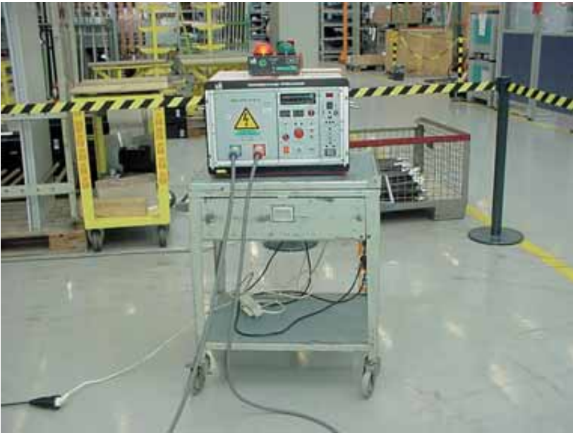
Bild 5 Durch Ausziehband abgegrenzter Prüfbereich für einen Prüfplatz ohne zwangsläufigen Berührungsschutz
