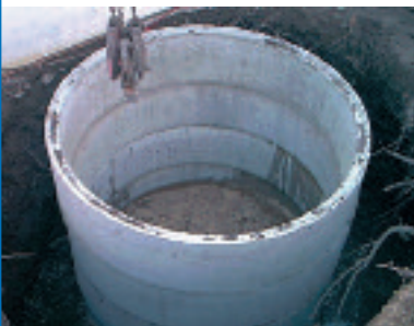
Sicherung der Grabenwände mit nicht-ferromagnetischen Verbau
