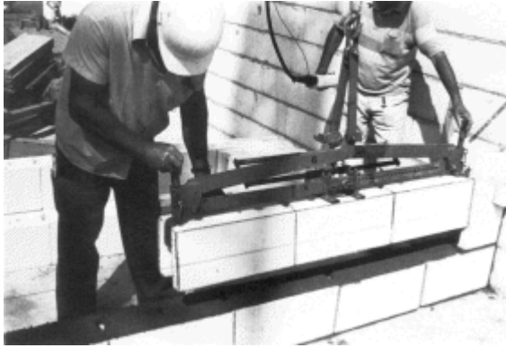
Bild 14: Greifzange mit zwei Prätzen für zwei und drei Steine
