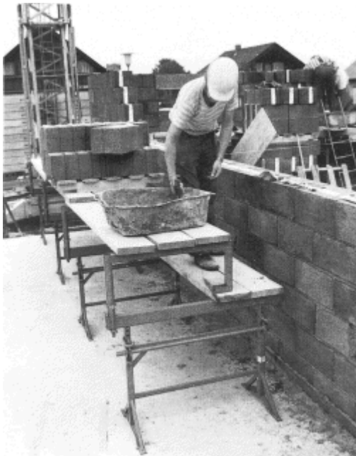
Bild 15: Maurergerüst mit 2 Ebenen
